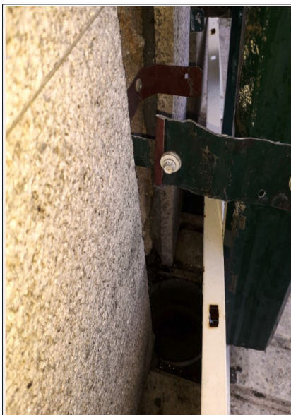
Imaxe de Google onde se aprecia o empotramento das baixantes na beirarrúa
